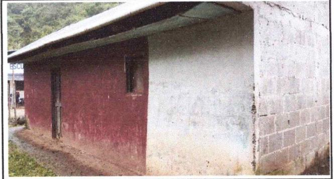
Foto 2: Cambio de techos: 32 láminas troquelados, 12 costanera de 3x2 y 8 costanera de 3x3, Cambio de puerta: largo 1. 88, ancho 92cm, ventana 1. Largo 63cm y ancho 63cm, ventana 2. 63 largo y 63 ancho, balcón 1. 76
